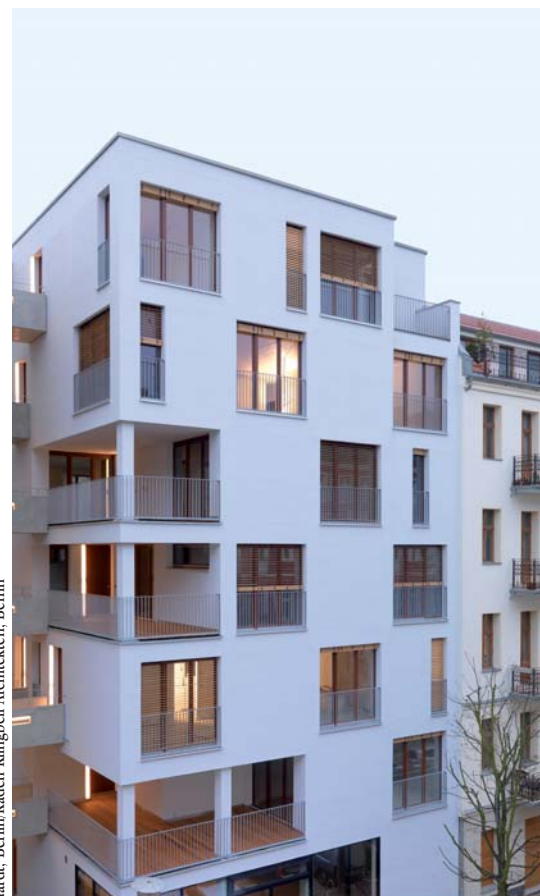
Sieben Wohnungen und eine Gewerbeeinheit entstanden unter der Regie der Architekten Tom Kaden und Tom Klingbeil, die selbst auch der Baugemeinschaft angehören.
